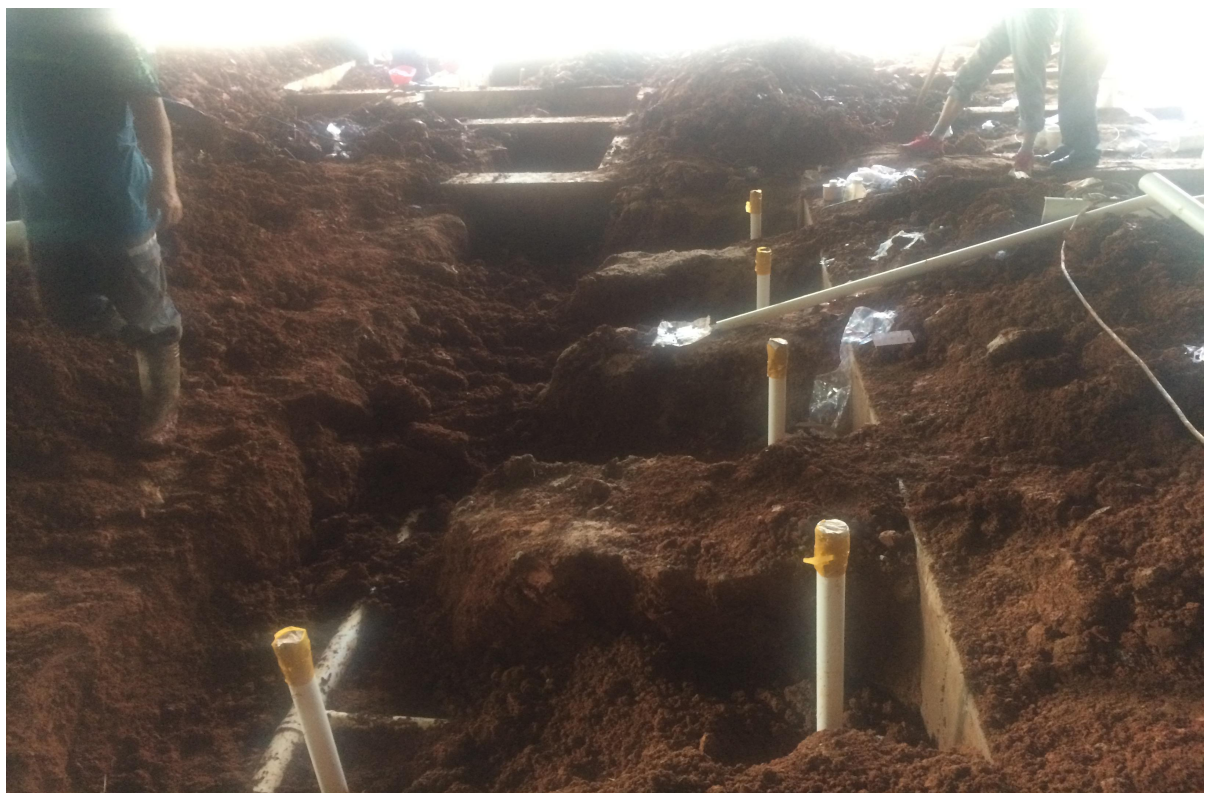
现场预埋一层卫生间 PVC 排水管；
