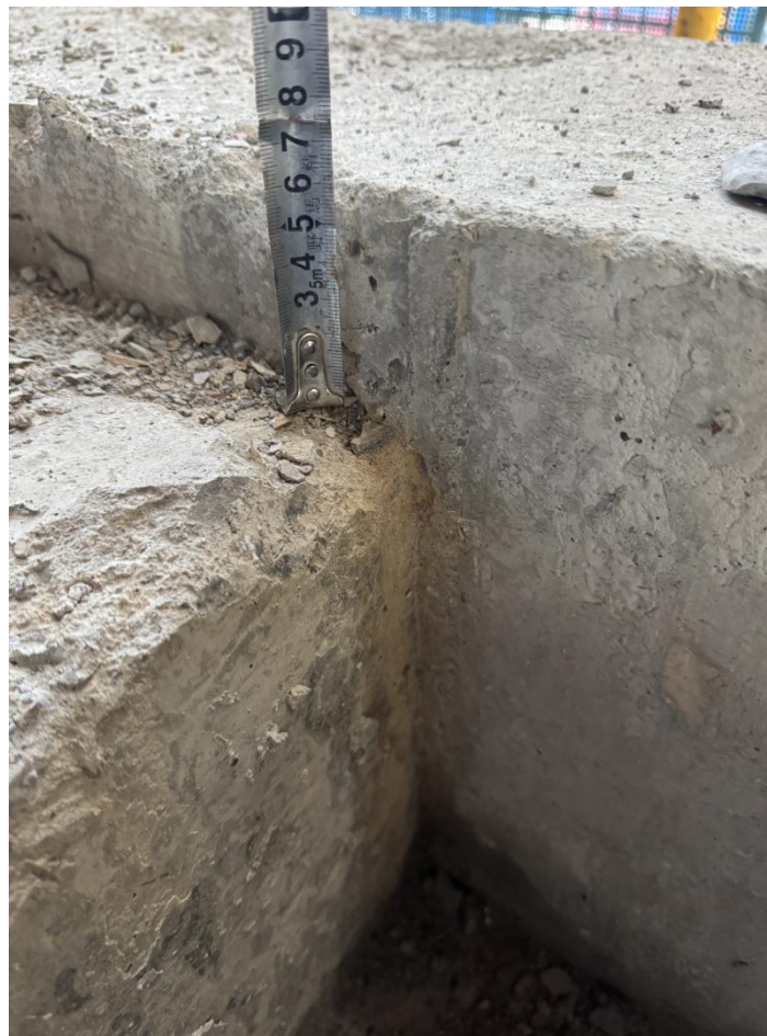
盥洗间降板测量
