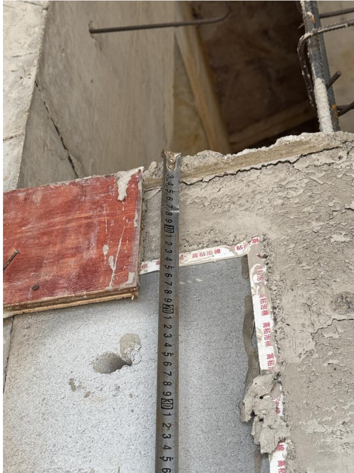
圈梁高度测量
