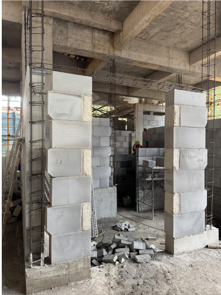
现场圈梁代替过梁
