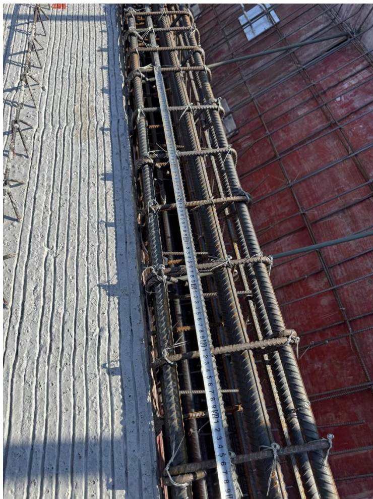
3号楼屋面梁钢筋测量
