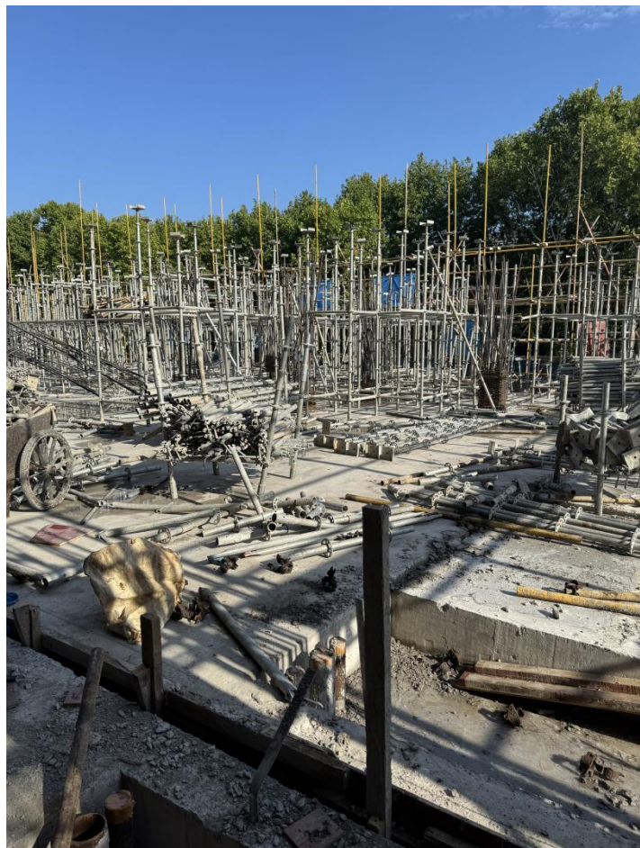
1号楼5层搭设脚手架
