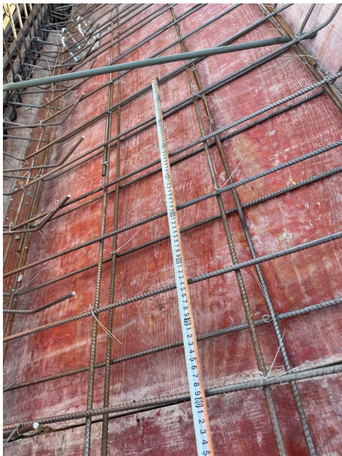
3号楼屋面钢筋测量
