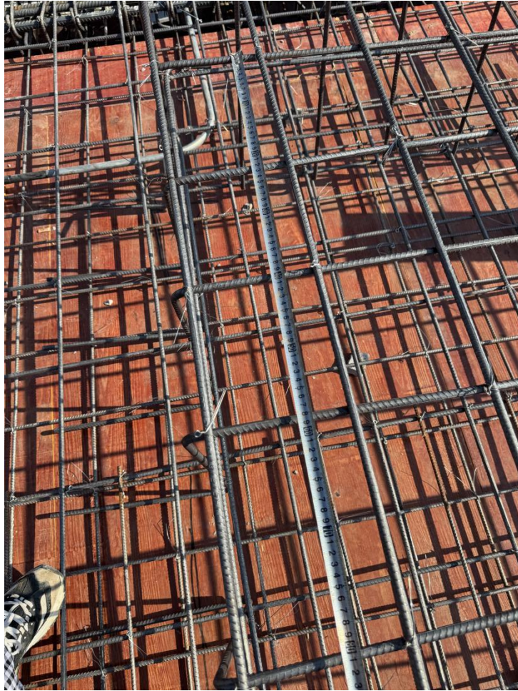
3号楼屋面设备基础钢筋测量
