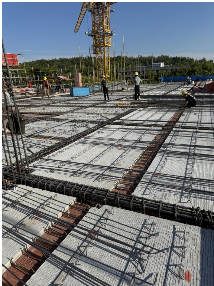
3号楼屋面叠合板安装
