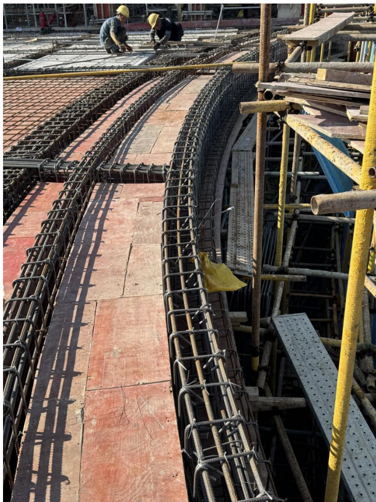
3号楼屋面弧形梁
