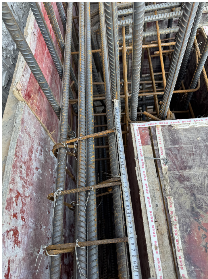
1 号楼 6 层梁起步钢筋测量
