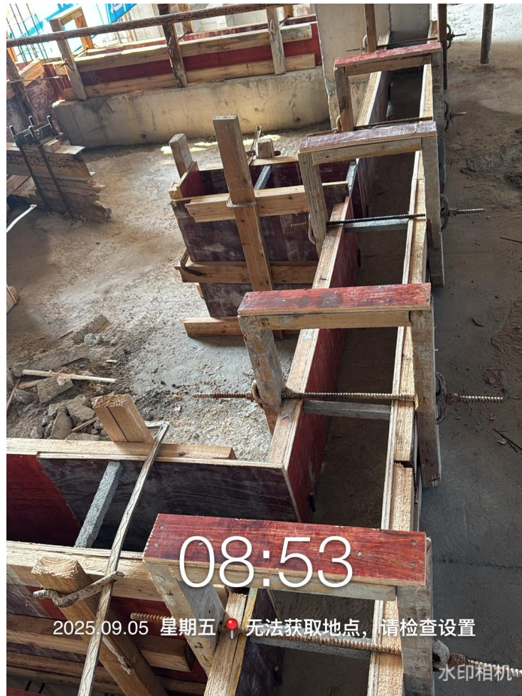
2号楼2层反坎支模板
