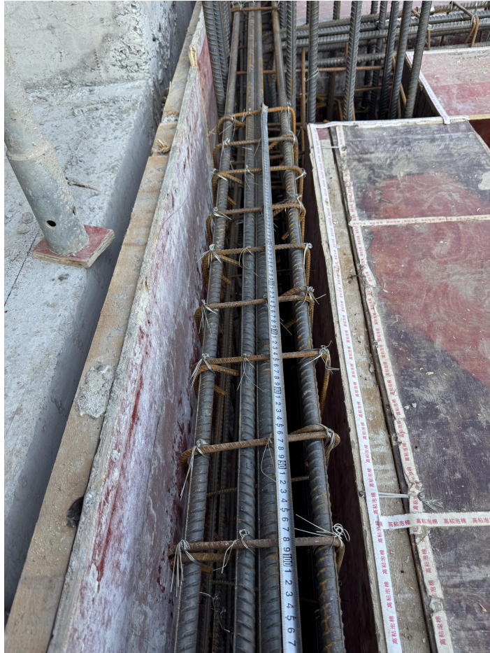
1 号楼 6 层梁钢筋测量
