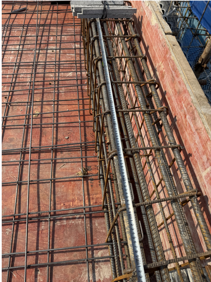
3 号楼花架梁钢筋测量
