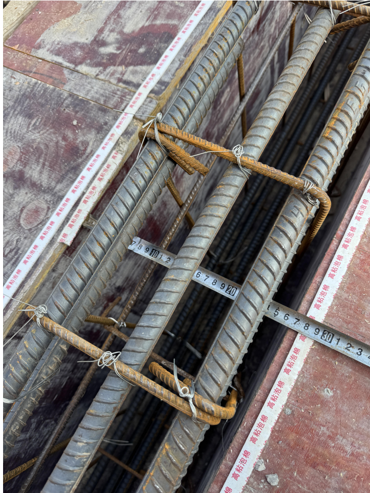
1 号楼 6 层梁宽、高测量
