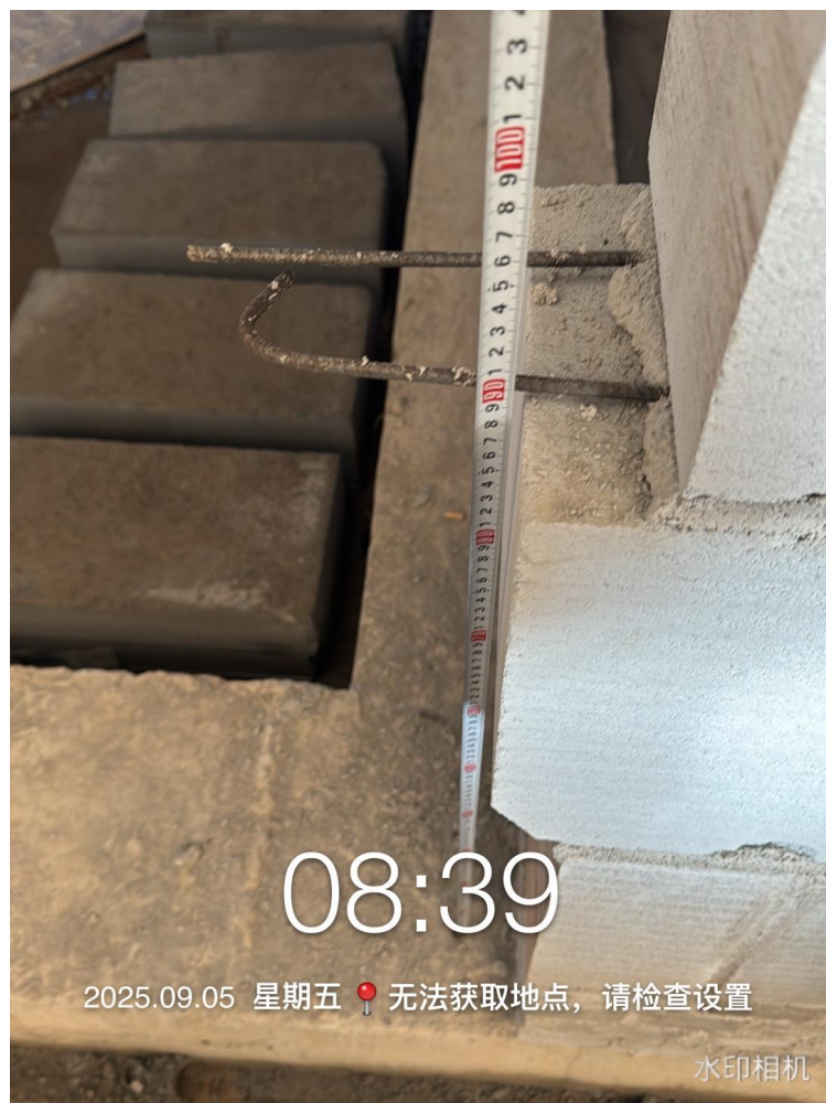
砌体加筋起步间距测量
