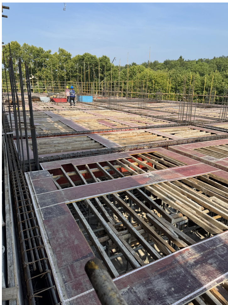
1 号楼 6 层支模板
