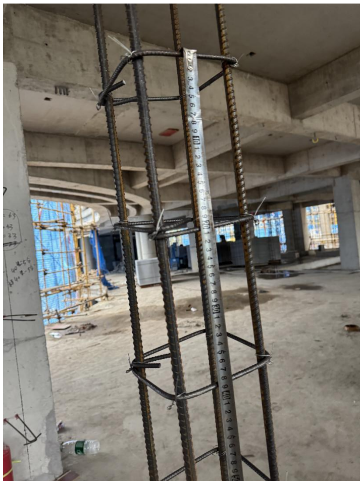
构造柱钢筋测量
