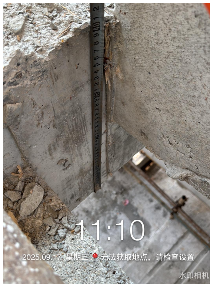
楼梯梁厚度测量
