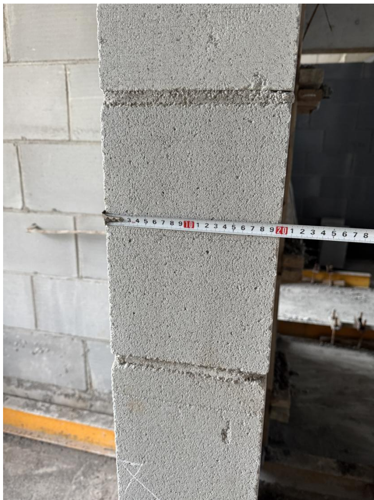
卫生间内隔墙测量
