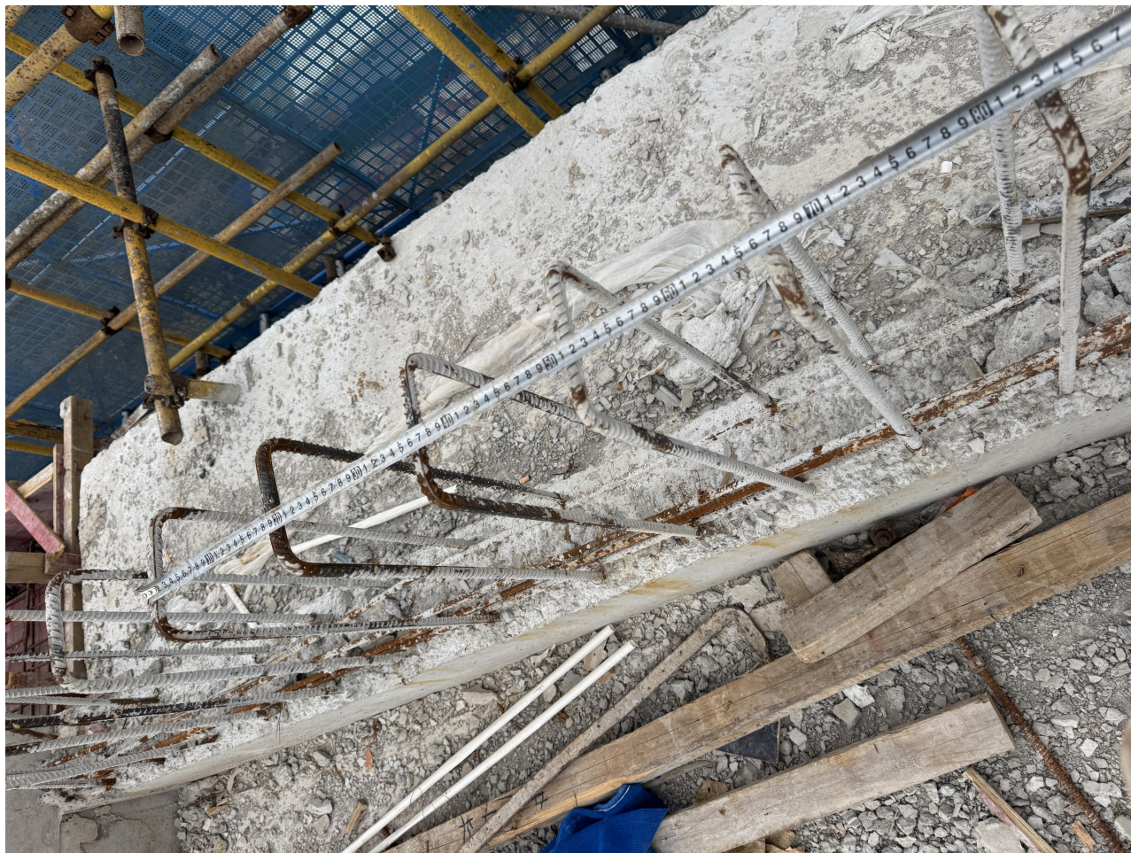
1 号楼屋面女儿墙钢筋测量
