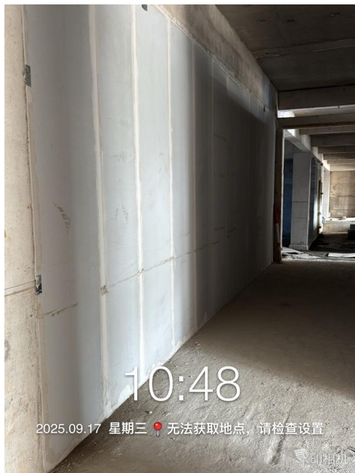
ALC 条板安装, 连接处网宽测量
