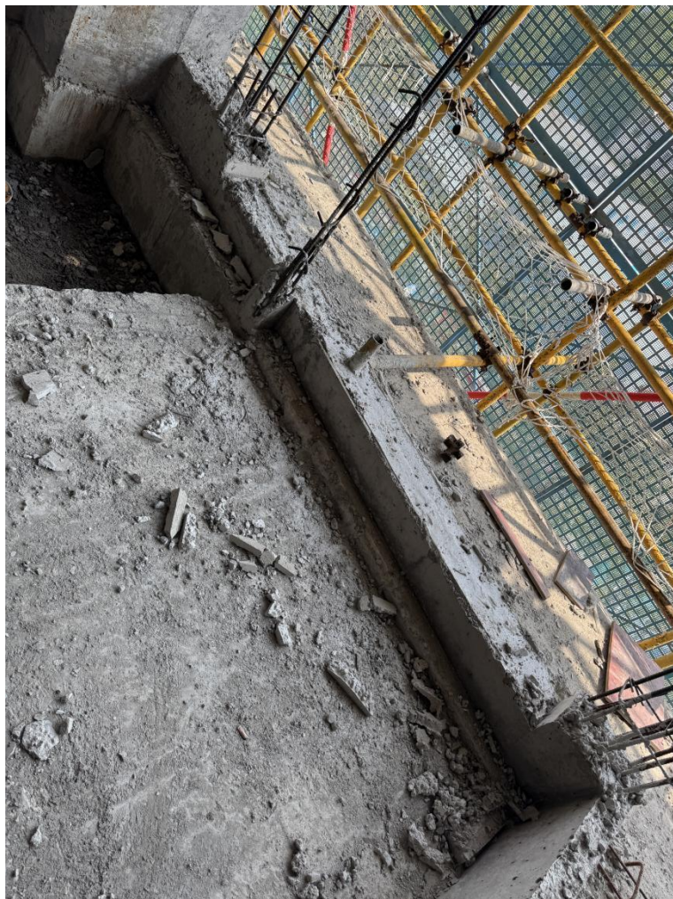
3 号楼靠体育馆卫生间反坎高度测量
