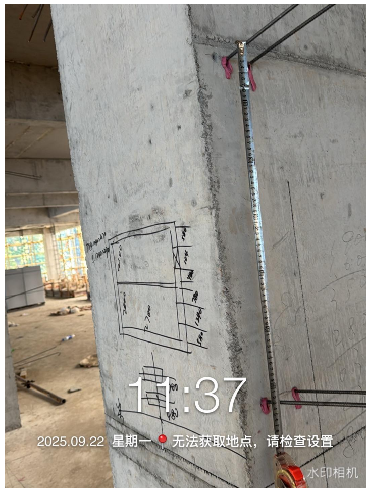
3 号楼 4 层植筋间距测量
