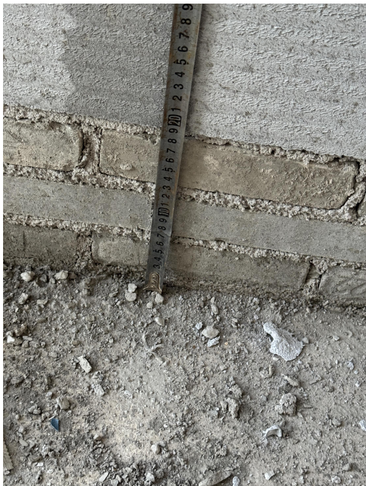
食堂 2 层斜墙基础测量
