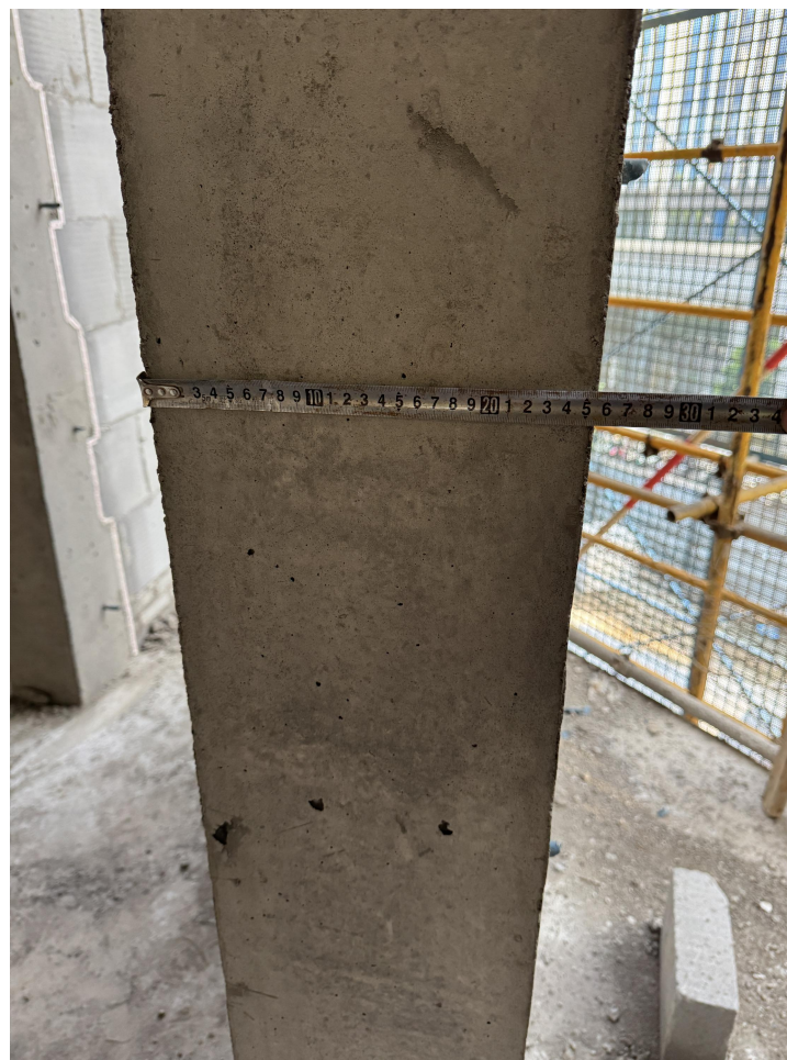
食堂 2 层斜墙宽度测量
