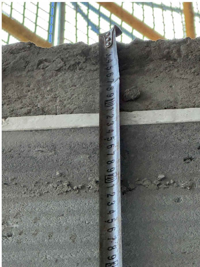
食堂 2 层圈梁高度测量
