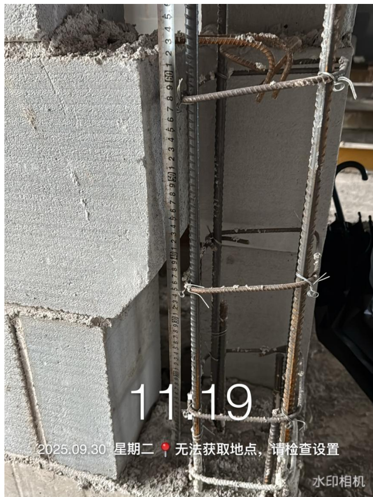
砌体加筋间距测量（间距 630mm）
