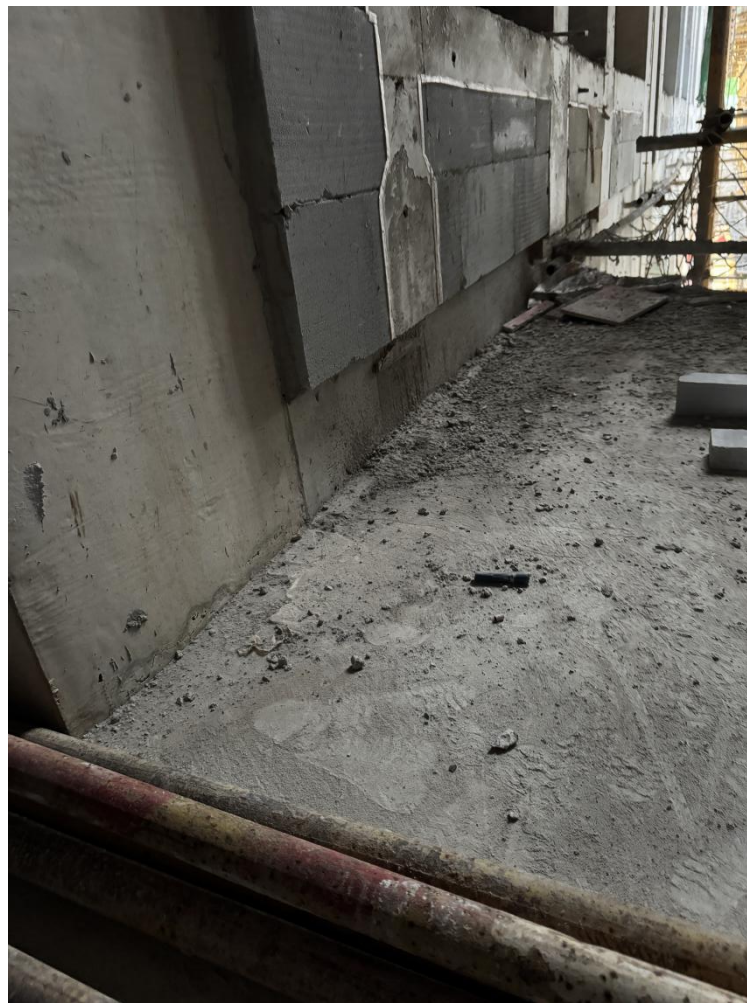
2 号楼 2 层自保温外墙（保温墙厚 250mm，反坎宽度 200mm）
