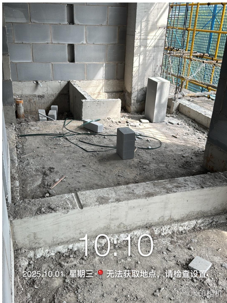
卫生间砌体施工
