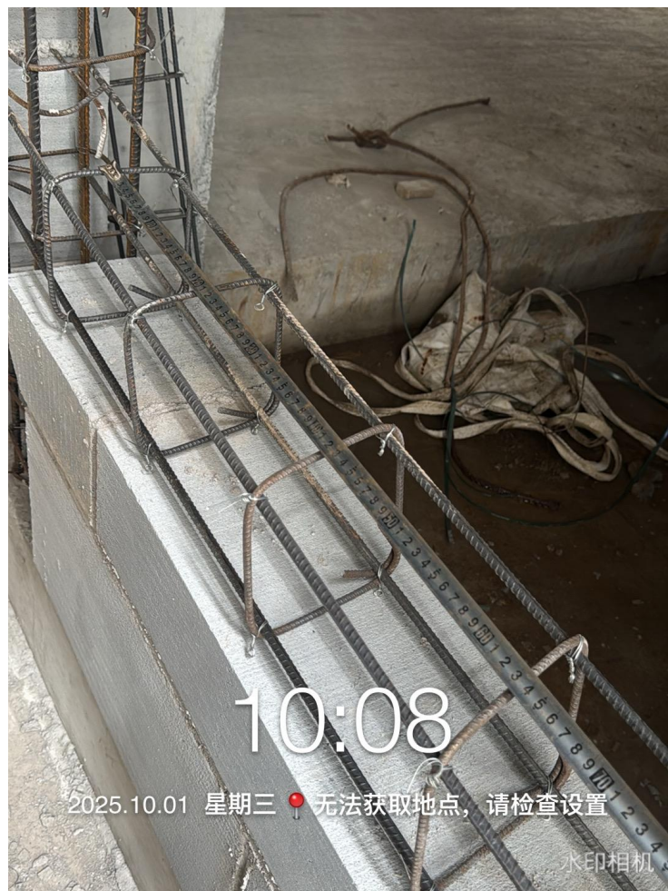
窗台压顶钢筋测量
