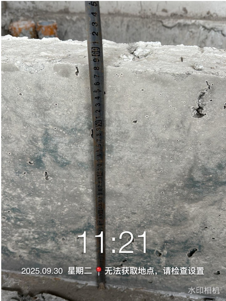
卫生间反坎高度测量
