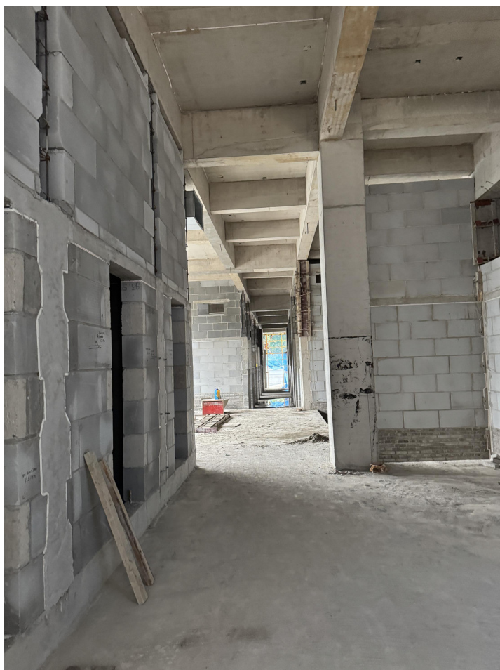
食堂砌筑及二构工程施工
