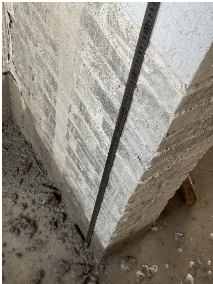
食堂卫生间砖基础测量
