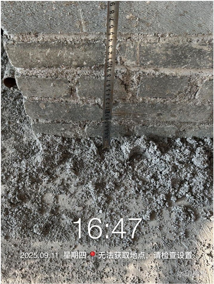
食堂电梯厅砖基础测量
