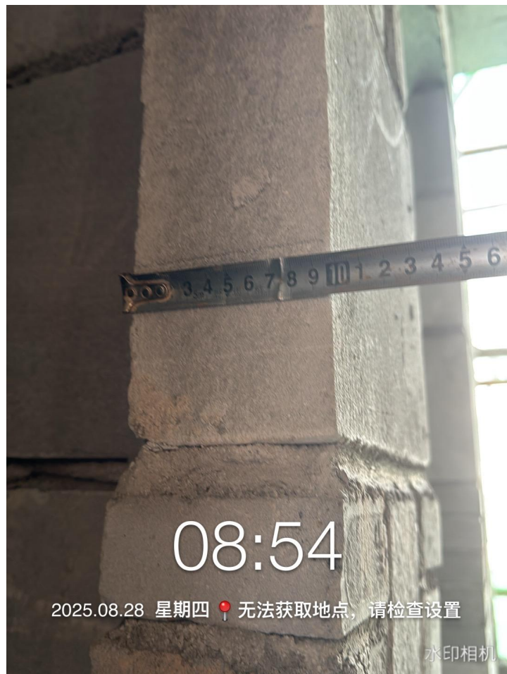
卫生间内隔墙测量
