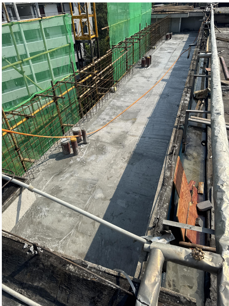
屋面板浇筑完成
