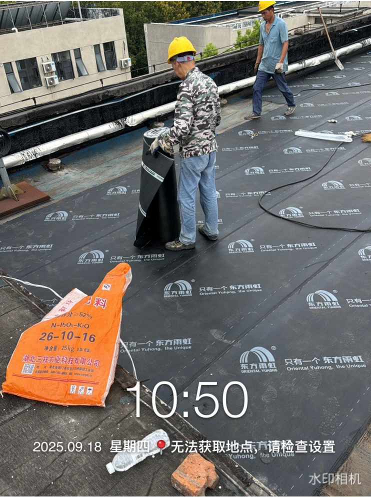
屋面防水施工测量
