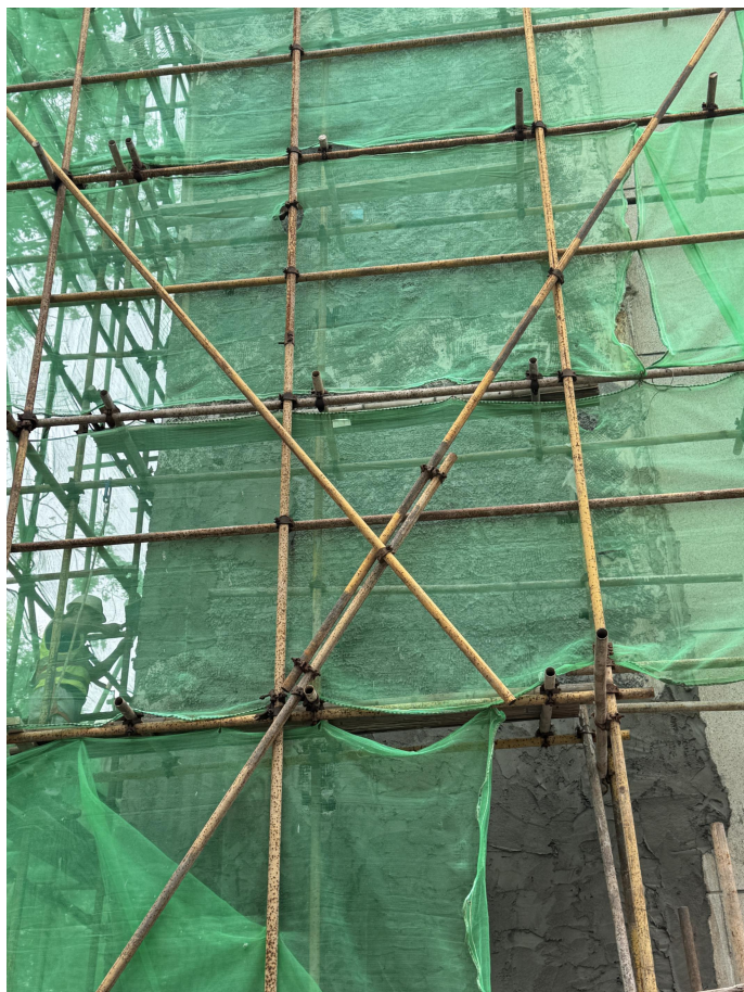
外墙抹灰施工
