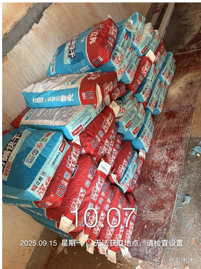
底层立邦石膏腻子材料进场
