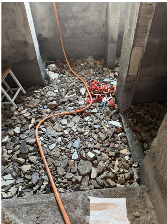
卫生间回填高度测量
