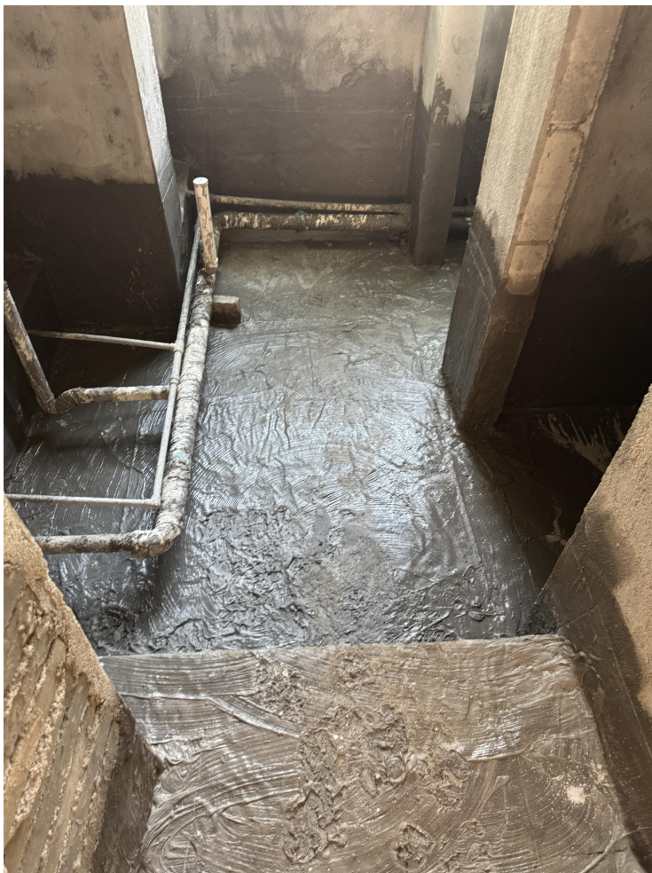
卫生间丙纶防水高度测量
