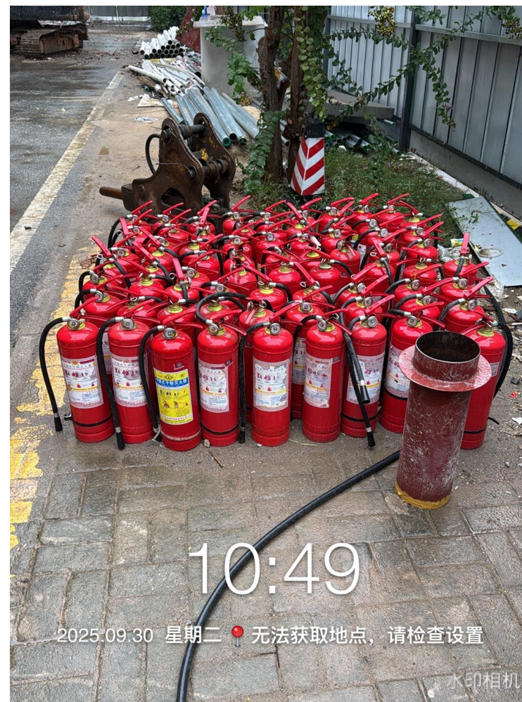
消火栓材料进场
