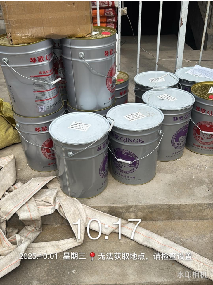
环氧地坪漆材料进场（材料品牌为琴歌）
