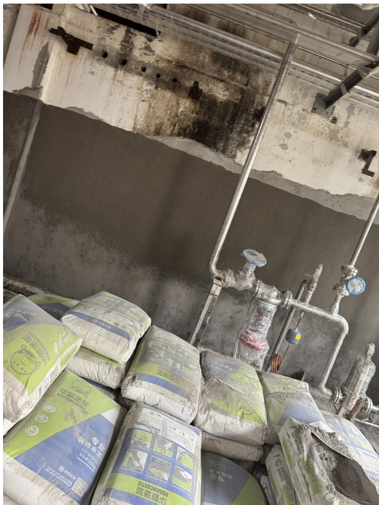
墙面抹灰及防水施工
